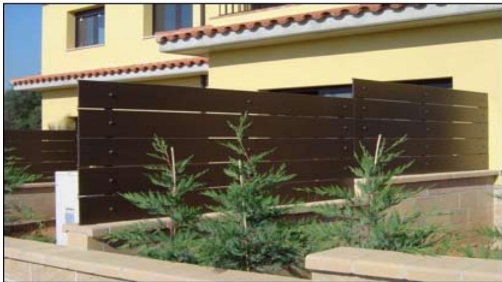
Vallas y separaciones
