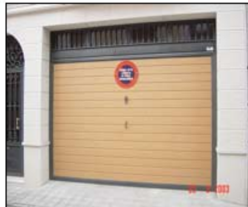
Puertas de garage
